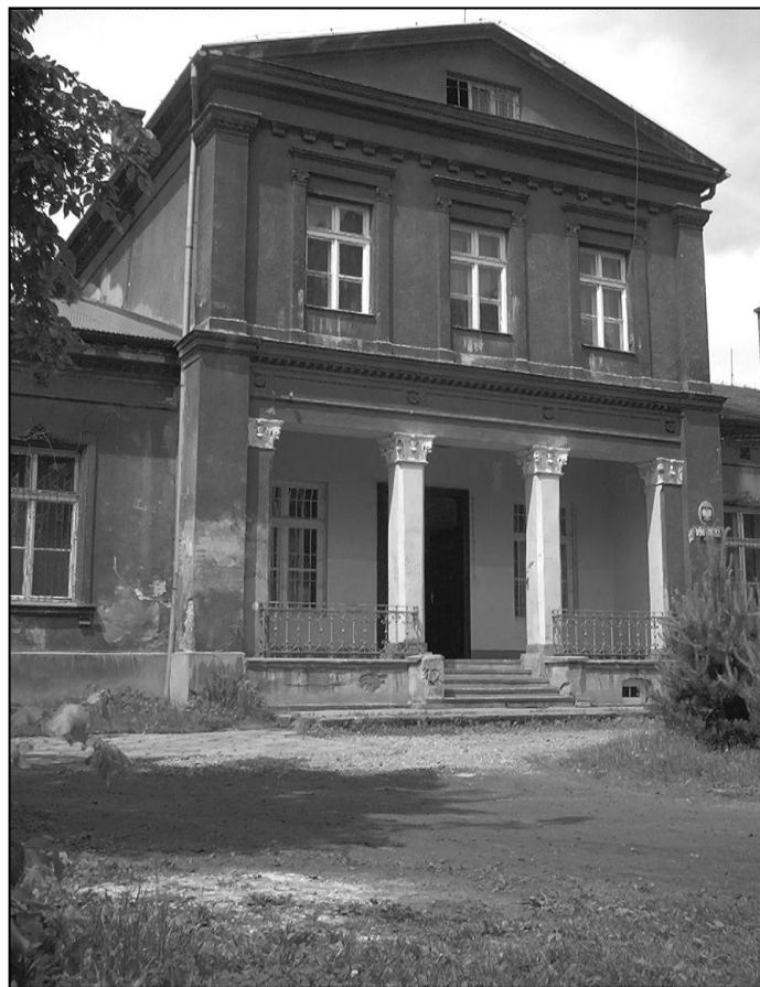
Dzięki uchwale szkoła w Bieżanowie zyska budynek położony obok obecnej siedziby szkoły
