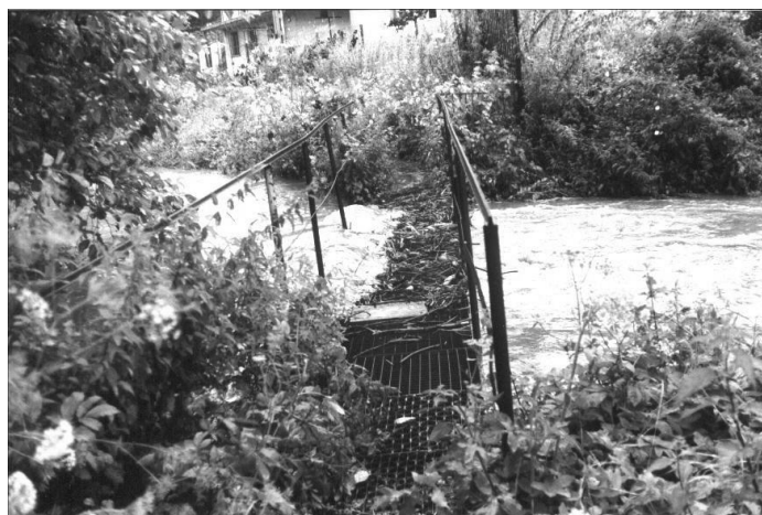
Kładka dla pieszych przy ulicy Szastera
