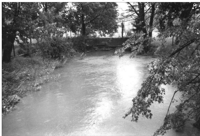
Stary most obok Rozdzielni Gazu przy ulicy Lipowskiego w całości pod wodą Serafy
